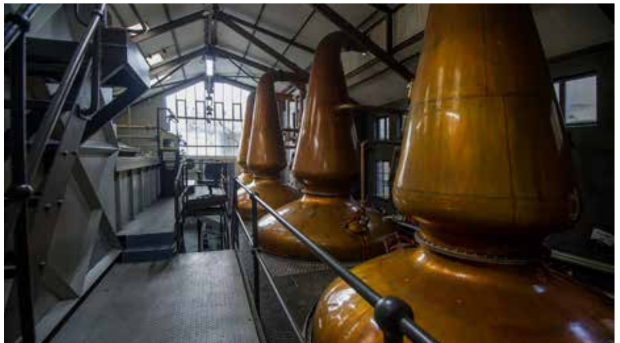
上：ジユラ蒸留所の2組の蒸留器
